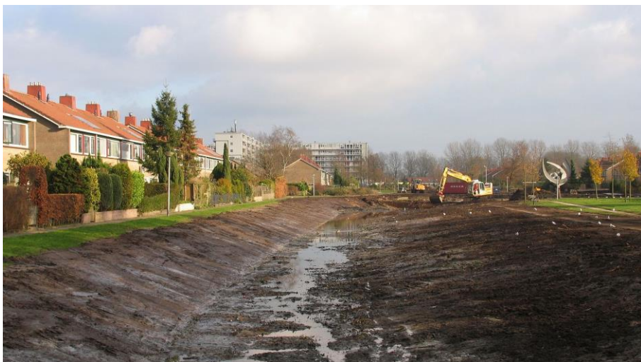
Het aanleggen van extra waterberging met natuurvriendelijke oevers in De Wiken in Drachten. Bron afbeelding: Date de Vries.
